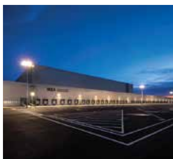
Kho Ikea / Malaysia Lắp đặt năm 2020
