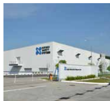
Kayaku Safety Systems / Malaysia Lắp đặt năm 2022
